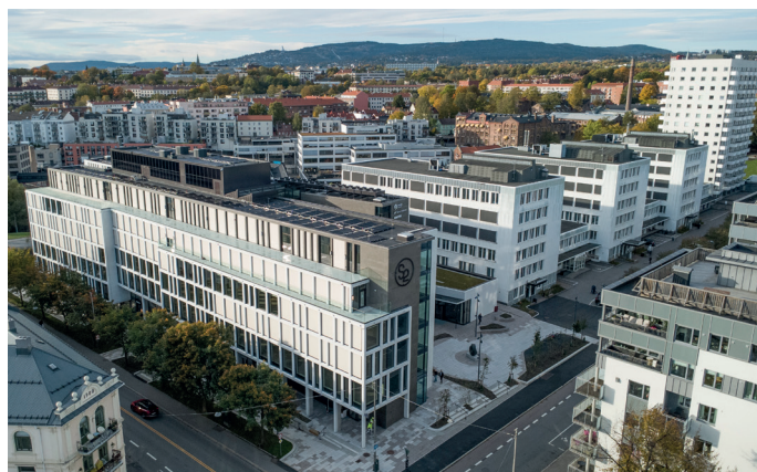
Sannergata 2 har blitt fornyet både utvendig og innvendig.
