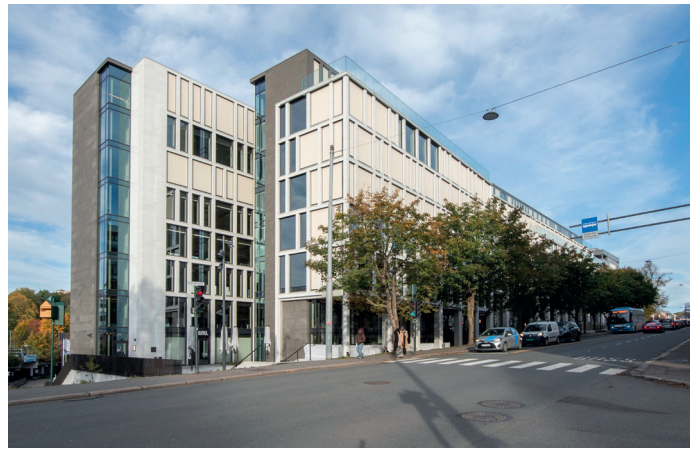
Fasadene mot Sannergata er åpnet opp og lysnet.
